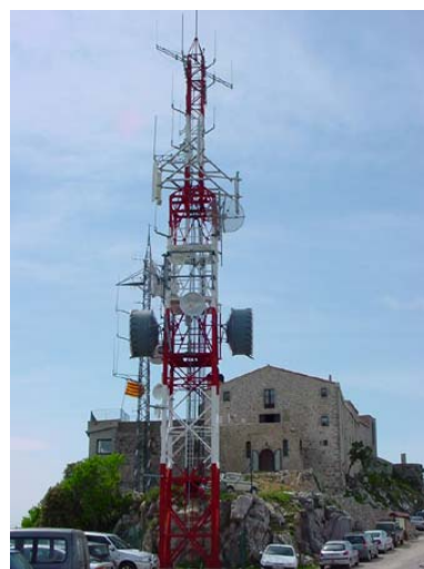
Antenes al santuari de la Mare de Déu del Mont
