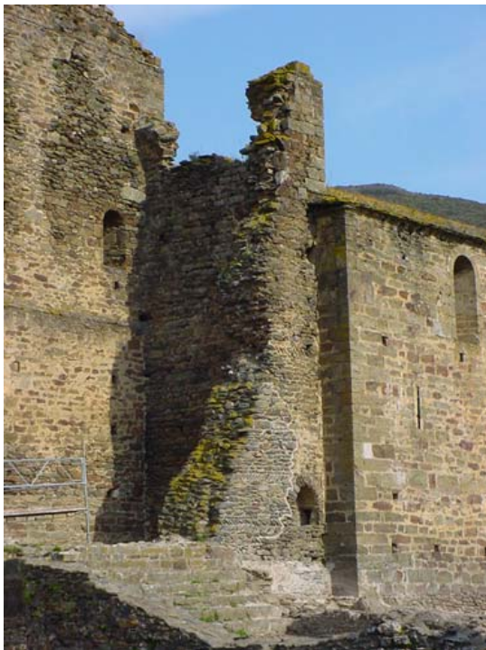
Restes del mur que devia formar la primitiva façana de l'església, amb un antic torn i les escales d'accés al temple
