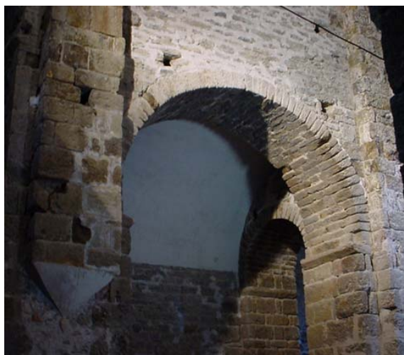
Arc entre la nau central i la septentrional, arc de la nau septentrional i pilastra adossada corresponent a l'arc toral
