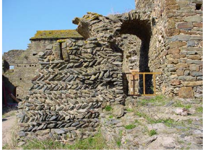
Opus spicatum i restes de l'absis lateral i la girola de l'església de la cel·la primitiva
