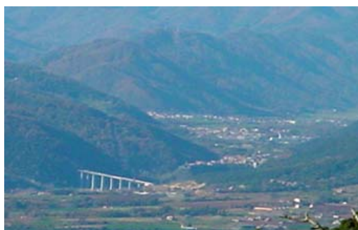
Viaducte de Castellfollit de la Roca
